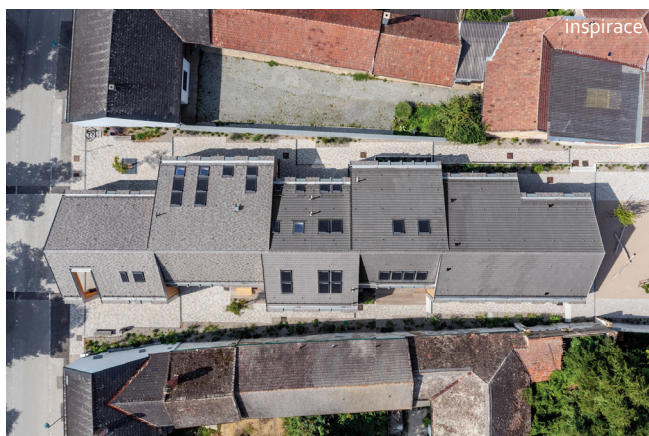
Obrázek 12 Komunitní centrum v obci Großweikersdorf v Rakousku, ve kterém se pod jednou střechou nachází různorodá občanská vybavenost – radnice, společenské prostory a lékařské ordinace. Autor: Smartvoll, 2020. Zdroj: EARCH.cz, 2021
