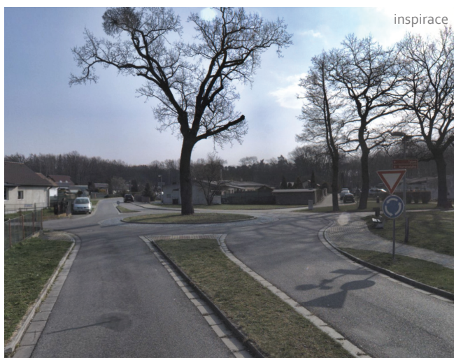
Obrázek 54 Příklad malé okružní křižovatky jako zklidňujícího (zpomalovacího) prvku zvyšujícího bezpečnost, Hakenova ulice v Rybitví, zdroj: mapy.cz, 2018
