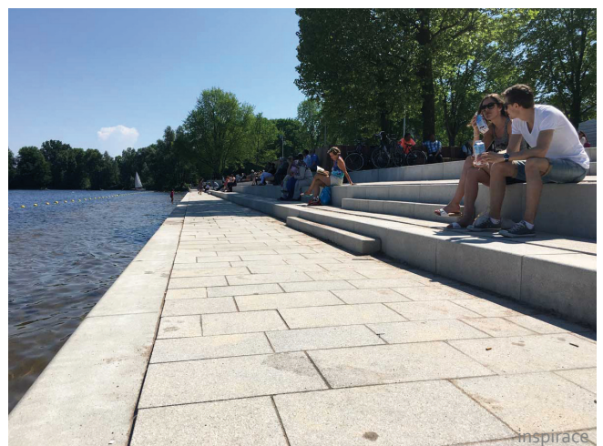
Obrázek 36 Zpevněné nábřeží, které umožňuje jak přístup k řece, tak sezení na pobytových schodech. Amsterdam, Nizozemí, autor: Grijzen/Stadsruimte, 2016. Zdroj: Landezine, 2017
