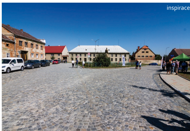
Obrázek 53 Rekonstrukce krajské silnice v obci Příkazy na Olomoucku, zdroj: Olomoucký kraj, 2019
