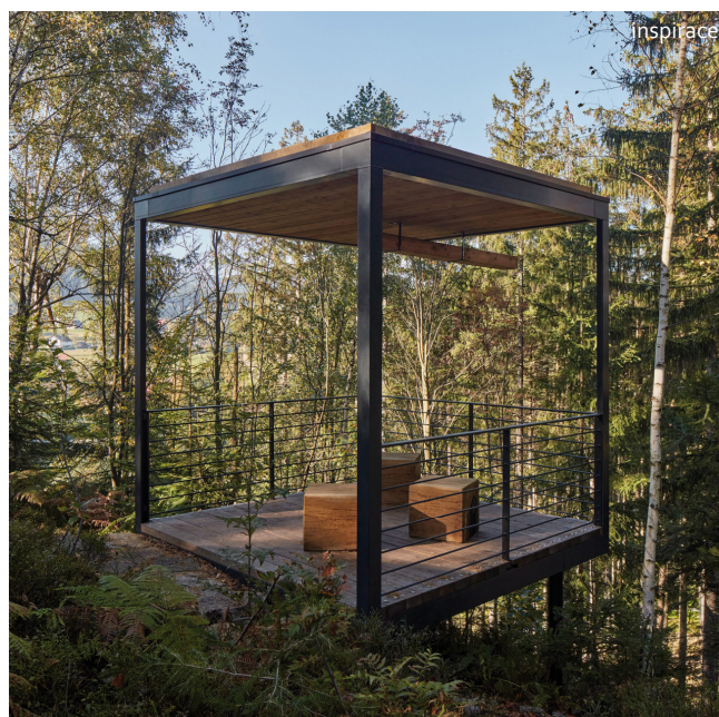
Obrázek 38 Vyhlídkový altán, projekt zpřístupnění bývalého lomu v Horní Bečvě, henkai architekti, zdroj: eArch.cz, 2022
