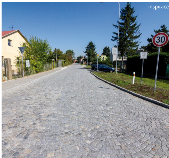
Obrázek 52 Rekonstrukce krajské silnice v obci Příkazy na Olomoucku, zdroj: Olomoucký kraj, 2019
