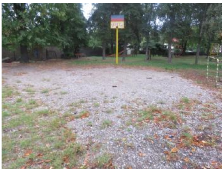
Dožívající štěrkové hřiště s pozůstatky betonových obrub
