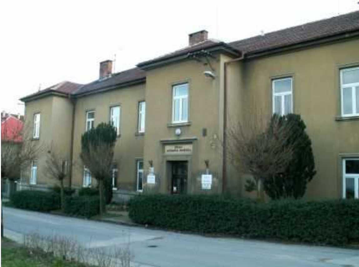
Budova základní školy
