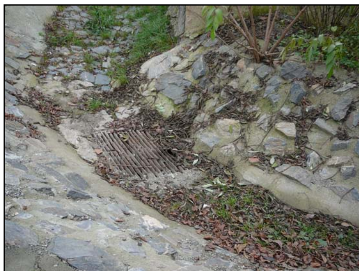
Foto /8/ Otevřený odvodňovací rigol v ulici Lužická.
