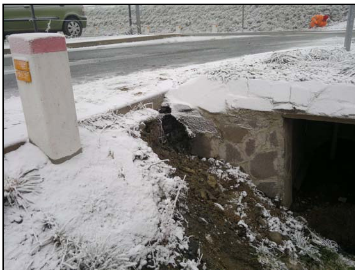
Foto /1/ Chybějící krajnice obslužných komunikací v lokalitě Anglický resort I. v Lešanech, zasypané příkopy a propustky.
