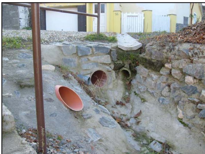
Foto /9/ Otevřené povrchové odvodnění v ulici Na Vršku.
