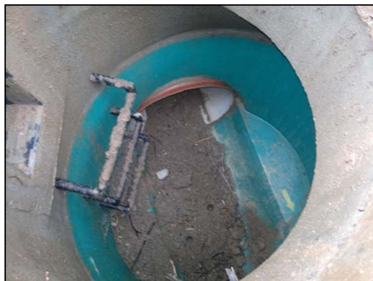
Foto /12/ V současnosti nefunkční dešťový přivaděč Lešany, DN 600.
