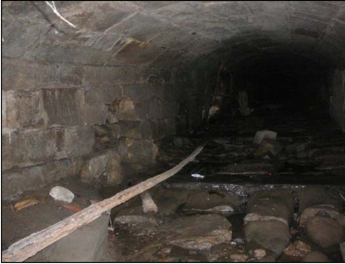
Foto /13/ Havárie boku ostění zděné hradební štoly - vlevo. Foto /14/ Zděná štola: havárie dna skluzu - vpravo.
