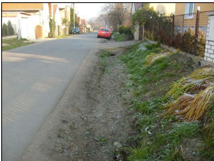
Foto /3/ Ulice V úvoze - celý profil příkopu je v některých místech prakticky ze 100% zanesen.
