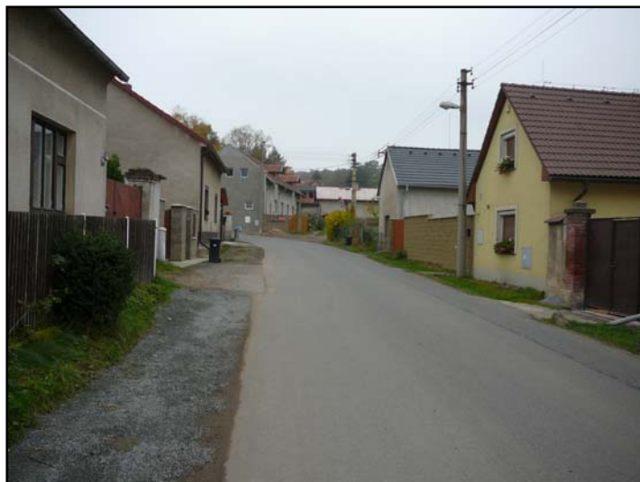
Foto /6/ Chybějící povrchové odvodnění komunikací v Lešanech.
