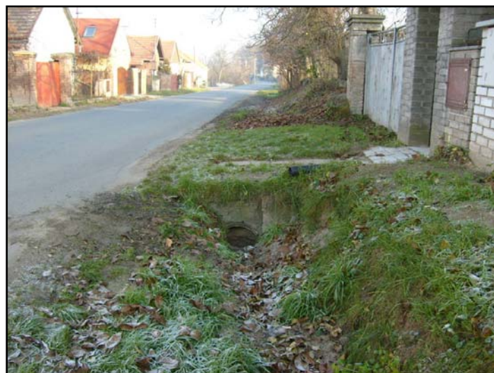
Foto /4/ Ulice V úvoze - celý profil některých propustků je prakticky ze 100% zanesen.
