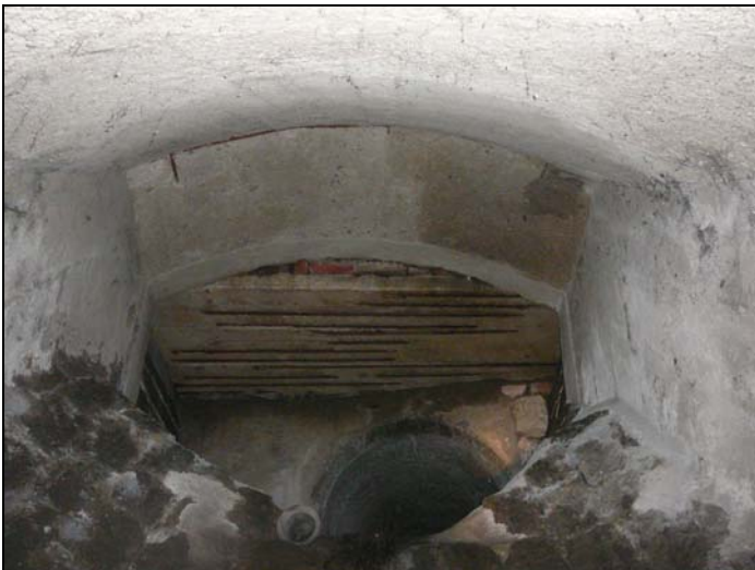
Foto /15/ Pohled na skluz a přechodový díl včetně zaústění potrubí DN 1200 do štoly. Foto /16/ Havárie ostění - vypadlá malta mezi kameny.
