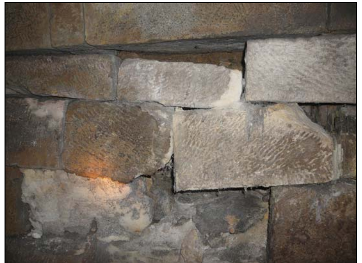
Foto /15/ Pohled na skluz a přechodový díl včetně zaústění potrubí DN 1200 do štoly. Foto /16/ Havárie ostění - vypadlá malta mezi kameny.
