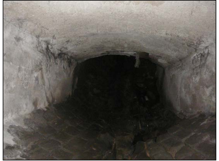
Foto /13/ Havárie boku ostění zděné hradební štoly - vlevo. Foto /14/ Zděná štola: havárie dna skluzu - vpravo.
