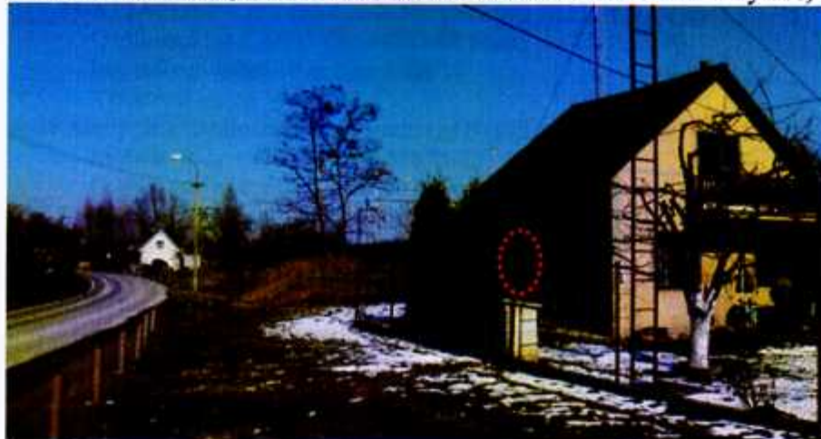
Obrázek 6 – Místo měření M2 v obci Podhořany (umístění mikrofonu znázorněno červeně; silnice II/616 v tomto úseku má sklon nivelety 0%)
