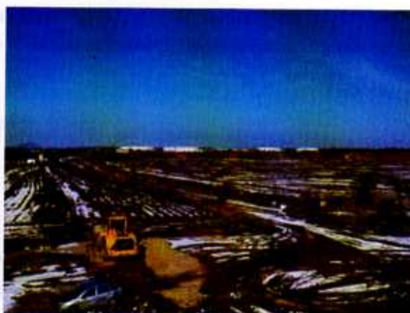
Severovýchodní pohled na místo záměru
